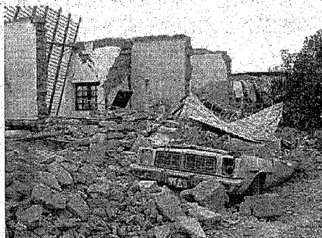
圖 3 抗震性能差的砌體結構
